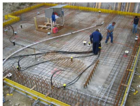
Armierung Bodenplatte
