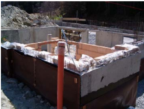
Untergeschoss mit Aussenanstrich
