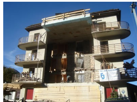
Ausbrucharbeiten / Oberste Decke betoniert
