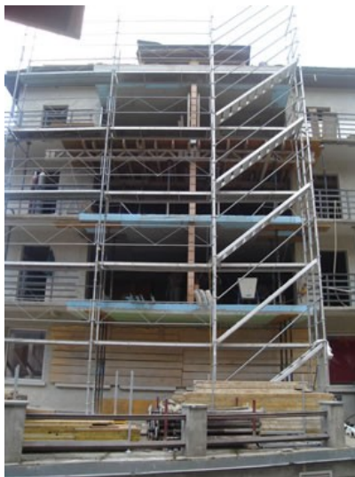
Decken betoniert / Gerüst
