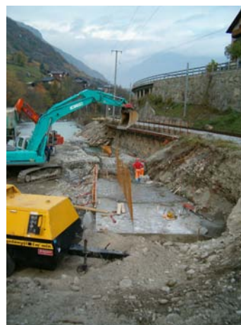
Fundament Bruchsteinmauer
