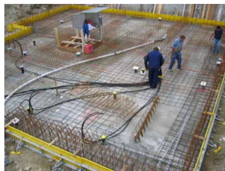
Armierung Bodenplatte
