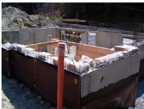
Untergeschoss mit Aussenanstrich
