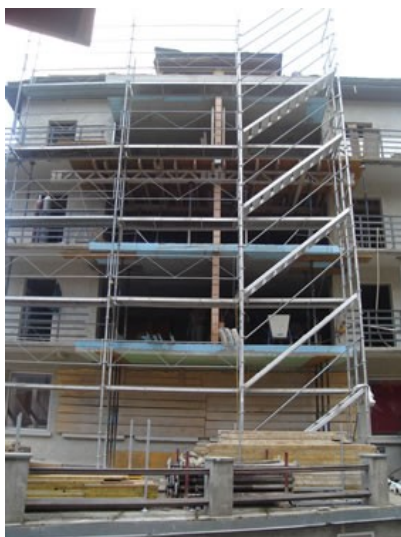
Decken betoniert / Gerüst
