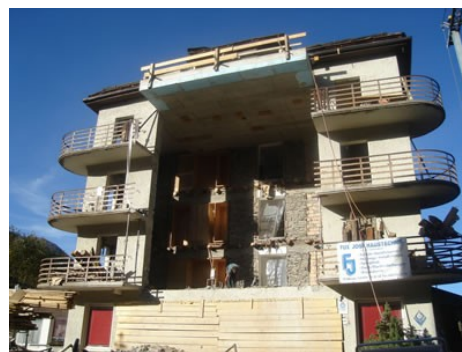
Ausbrucharbeiten / Oberste Decke betoniert
