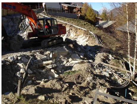
Aushubarbeiten mit 23 to Bagger
